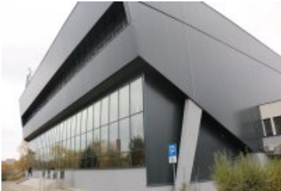
• Hala sportowa po termomodernizacji
