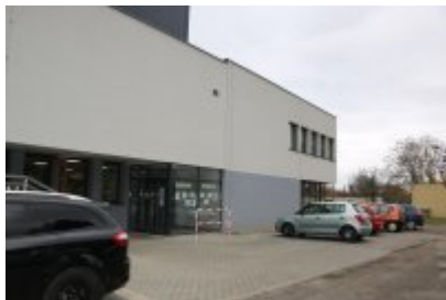
Hala sportowa po termomodernizacji
