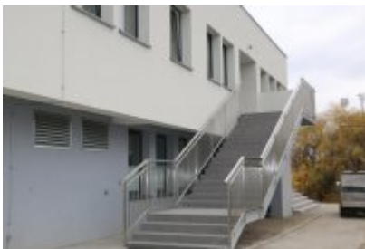
• Hala sportowa po termomodernizacji
