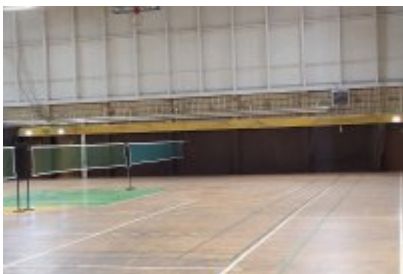
• Hala sportowa po termomodernizacji
