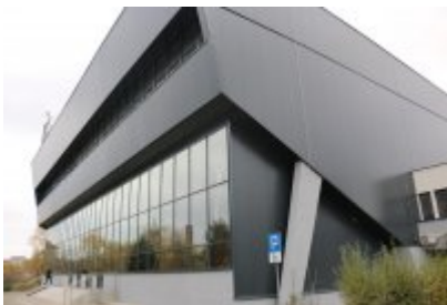
• Hala sportowa po termomodernizacji
