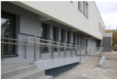
• Hala sportowa po termomodernizacji
