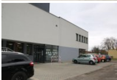
• Hala sportowa po termomodernizacji
