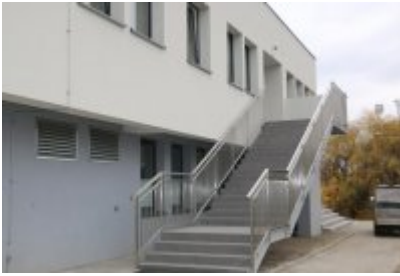
• Hala sportowa po termomodernizacji
