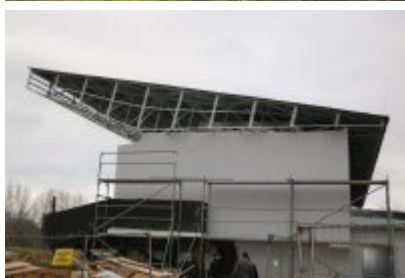
• Hala sportowa po termomodernizacji
