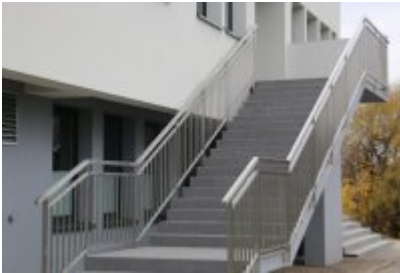
• Hala sportowa po termomodernizacji
