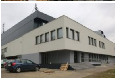
• Hala sportowa po termomodernizacji
