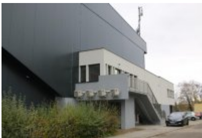
• Hala sportowa po termomodernizacji
