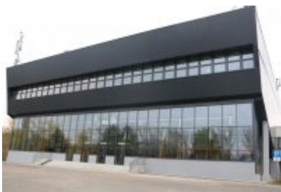
• Hala sportowa po termomodernizacji
