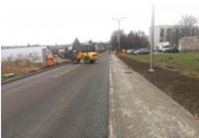
• Ulica Siemianowicka gotowa
