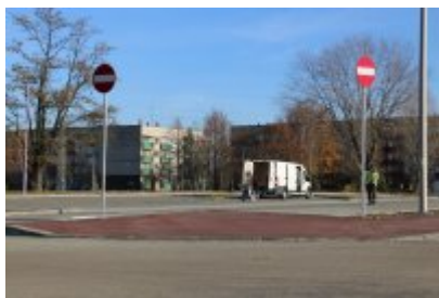
• Obwodnica osiedla Piłsudskiego w Czeladzi
