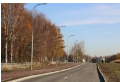
• Obwodnica osiedla Piłsudskiego w Czeladzi
