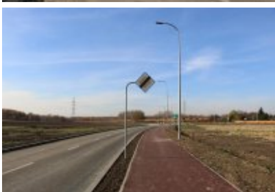
• Obwodnica osiedla Piłsudskiego w Czeladzi
