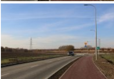
• Obwodnica osiedla Piłsudskiego w Czeladzi
