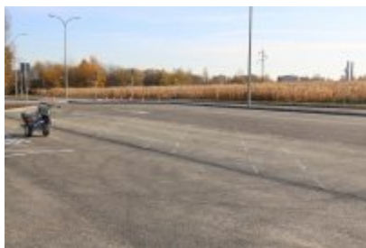
• Obwodnica osiedla Piłsudskiego w Czeladzi
