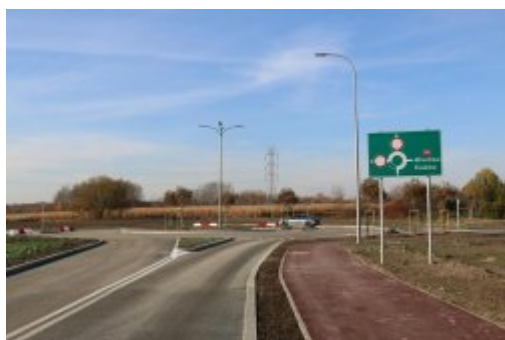
Obwodnica osiedla Piłsudskiego
