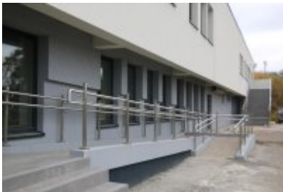
Hala sportowa po termomodernizacji
