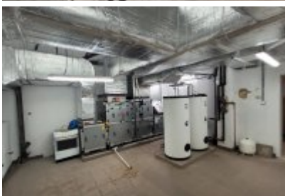
• Hala sportowa po termomodernizacji
