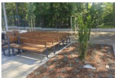
Drzewa wokół remontowanej cechowni
