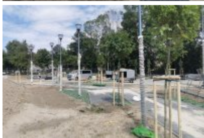
• Drzewa wokół remontowanej cechowni
