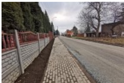
• Ulica Siemianowicka gotowa
