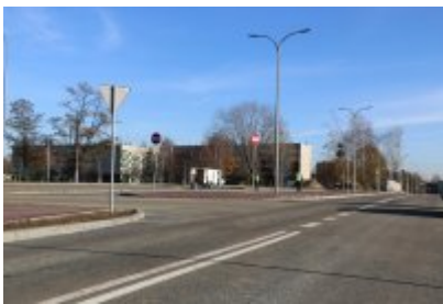
• Obwodnica osiedla Piłsudskiego w Czeladzi
