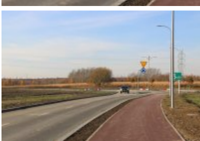
• Obwodnica osiedla Piłsudskiego w Czeladzi
