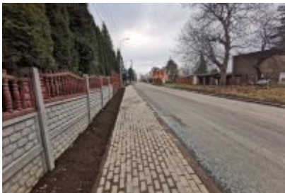
• Ulica Siemianowicka gotowa
