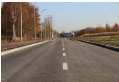
• Obwodnica osiedla Piłsudskiego w Czeladzi
