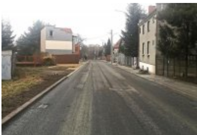
Ulica Siemianowicka gotowa
