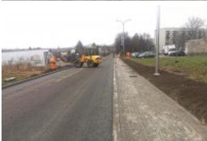
• Ulica Siemianowicka gotowa
