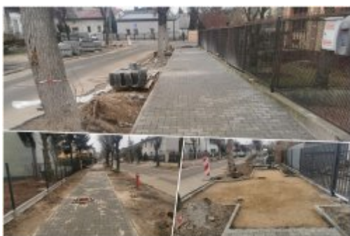
Remont ulicy Polnej
