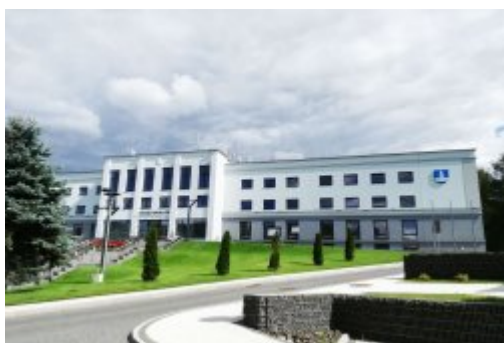
Wyremontowany budynek UM
