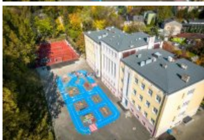
• Modernizacja terenu przyszkolnego w SP4
