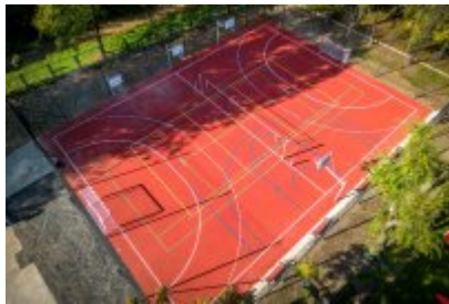
Modernizacja terenu przyszkolnego w SP4
