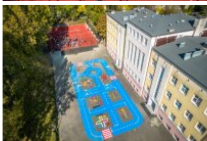
• Modernizacja terenu przyszkolnego w SP4
