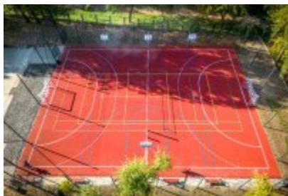
Modernizacja terenu przyszkolnego w SP4
