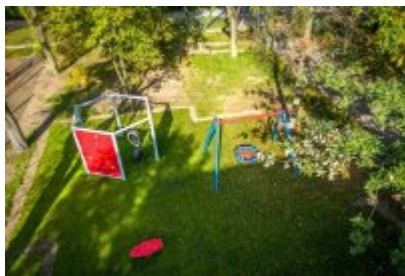
Modernizacja terenu przyszkolnego w SP4
