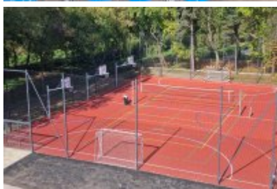
• Modernizacja terenu przyszkolnego w SP4
