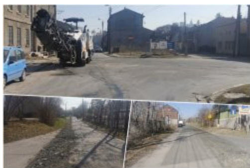
Kompleksowy remont ulicy Niwa
