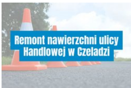
Remont ulicy Handlowej
