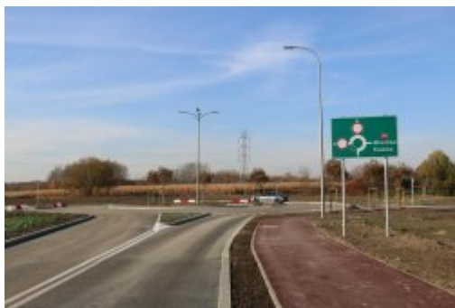
Obwodnica osiedla Piłsudskiego
