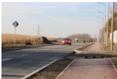
• Obwodnica osiedla Piłsudskiego w Czeladzi
