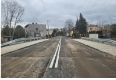
• Nowopogońska już przejezdna
