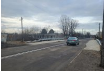
• Nowopogońska już przejezdna
