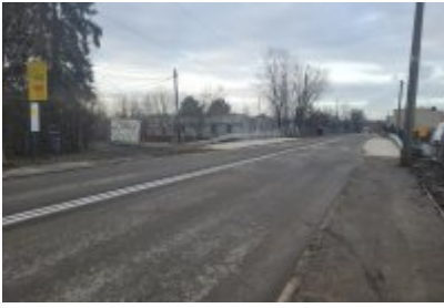
• Nowopogońska już przejezdna
