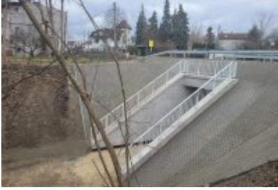
• Nowopogońska już przejezdna
