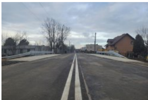
Nowopogońska już przejezdna
