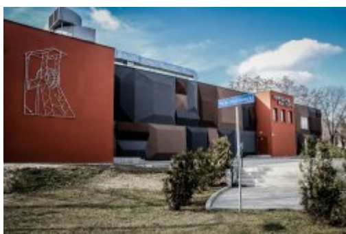
Kopalnia Kultury na podium!
