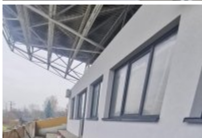
• Remont trybuny stadionu
