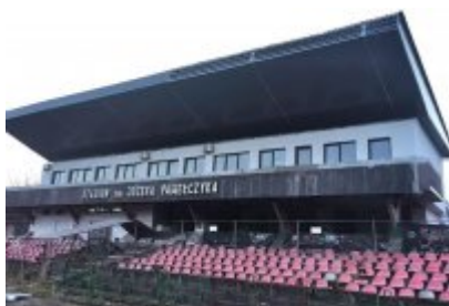
• Remont trybuny stadionu
