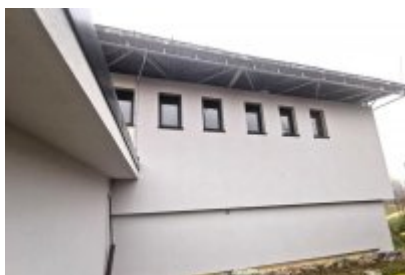
• Remont trybuny stadionu
