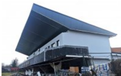
• Remont trybuny stadionu
