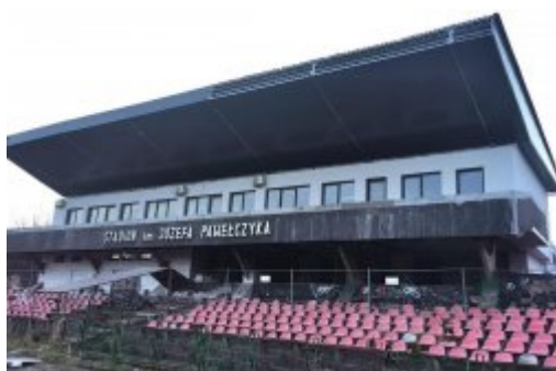
Remont trybuny stadionu
