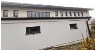
Remont trybuny stadionu
