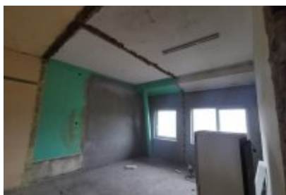
• Remont trybuny stadionu
