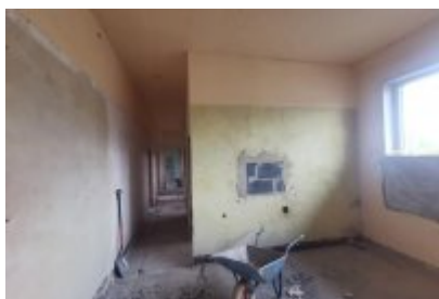
• Remont trybuny stadionu
