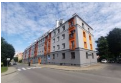
Termomodernizacja budynku komunalnego przy ul. Tuwima
