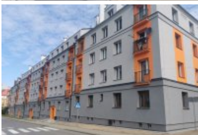
Termomodernizacja budynku komunalnego przy ul. Tuwima
