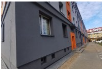
Termomodernizacja budynku komunalnego przy ul. Tuwima
