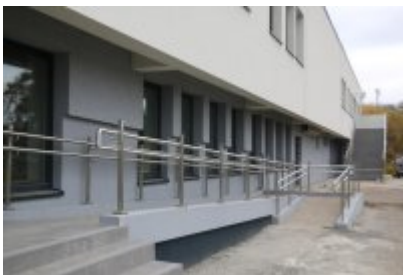
Hala sportowa po termomodernizacji
