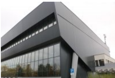
• Hala sportowa po termomodernizacji
