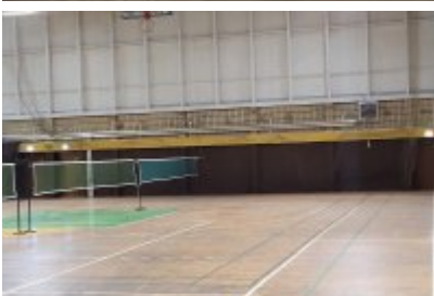
• Hala sportowa po termomodernizacji
