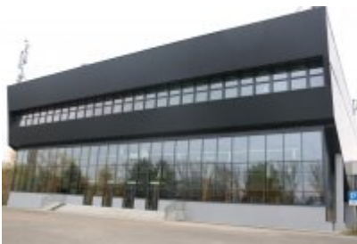
• Hala sportowa po termomodernizacji
