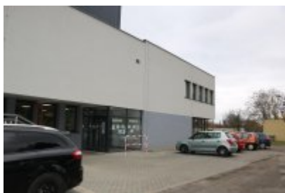
• Hala sportowa po termomodernizacji
