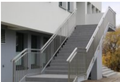
• Hala sportowa po termomodernizacji
