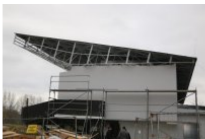
• Hala sportowa po termomodernizacji
