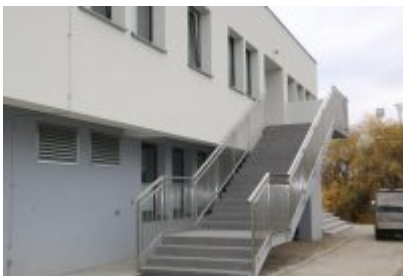
• Hala sportowa po termomodernizacji
