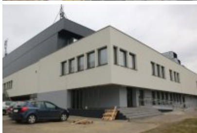
• Hala sportowa po termomodernizacji
