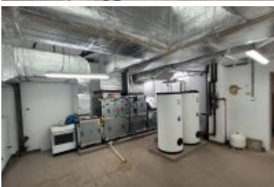
• Hala sportowa po termomodernizacji
