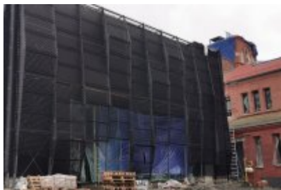
Remont dawnej cechowni KWK Saturn w Czeladzi
