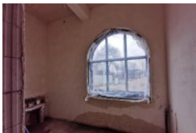
Remont dawnej cechowni KWK Saturn w Czeladzi
