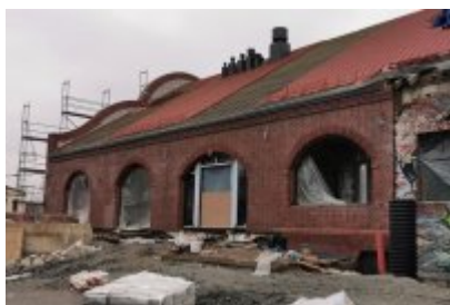
Remont dawnej cechowni KWK Saturn w Czeladzi
