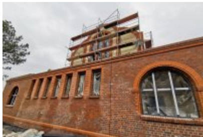
Remont dawnej cechowni KWK Saturn w Czeladzi
