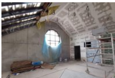
• Remont dawnej cechowni KWK Saturn w Czeladzi
