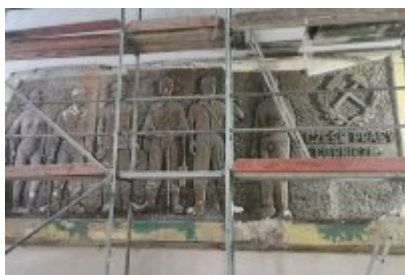
• Remont dawnej cechowni KWK Saturn w Czeladzi
