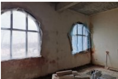
Remont dawnej cechowni KWK Saturn w Czeladzi
