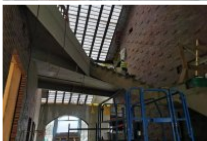
• Remont dawnej cechowni KWK Saturn w Czeladzi
