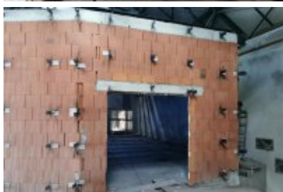
• Remont dawnej cechowni KWK Saturn w Czeladzi
