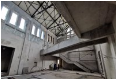
Remont dawnej cechowni KWK Saturn w Czeladzi
