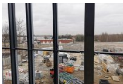
• Remont dawnej cechowni KWK Saturn w Czeladzi
