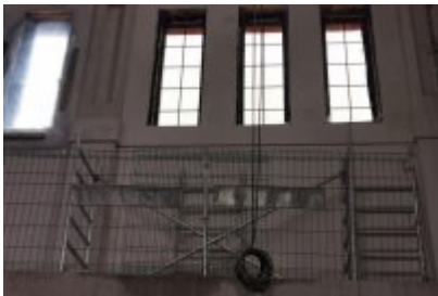
Remont dawnej cechowni KWK Saturn w Czeladzi
