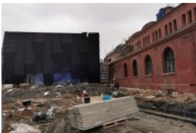
Remont dawnej cechowni KWK Saturn w Czeladzi
