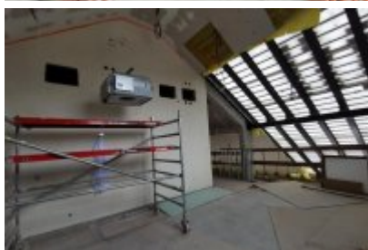
• Remont dawnej cechowni KWK Saturn w Czeladzi
