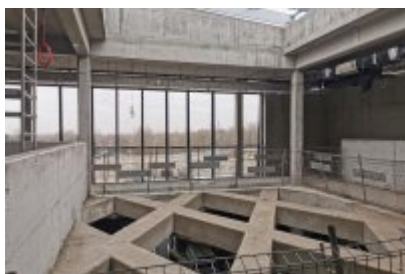
• Remont dawnej cechowni KWK Saturn w Czeladzi
