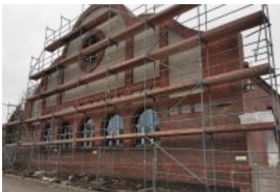
Remont dawnej cechowni KWK Saturn w Czeladzi
