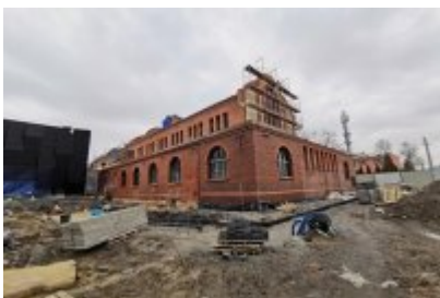
Remont dawnej cechowni KWK Saturn w Czeladzi
