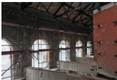
• Remont dawnej cechowni KWK Saturn w Czeladzi
