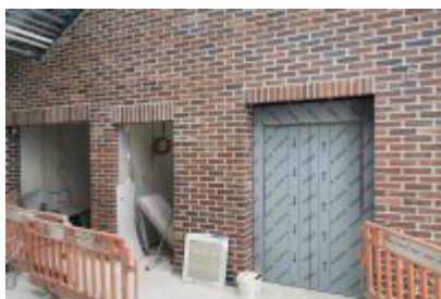
• Remont dawnej cechowni KWK Saturn w Czeladzi
