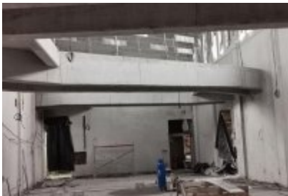
Remont dawnej cechowni KWK Saturn w Czeladzi
