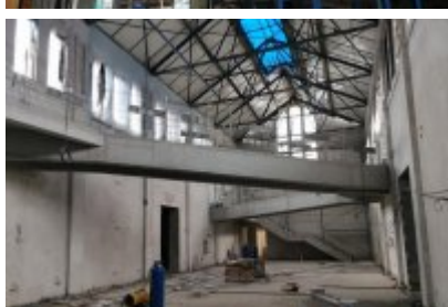
• Remont dawnej cechowni KWK Saturn w Czeladzi
