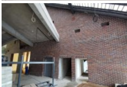
• Remont dawnej cechowni KWK Saturn w Czeladzi
