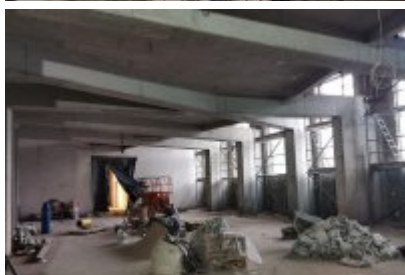
• Remont dawnej cechowni KWK Saturn w Czeladzi
