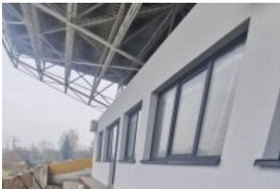
• Remont trybuny stadionu
