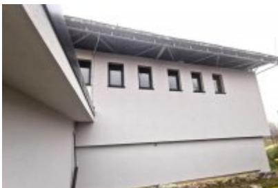
• Remont trybuny stadionu
