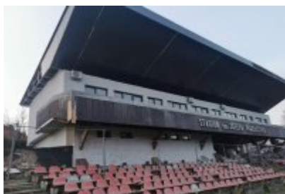
Remont trybuny stadionu
