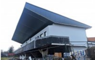
• Remont trybuny stadionu
