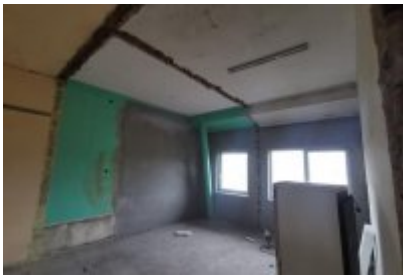
• Remont trybuny stadionu
