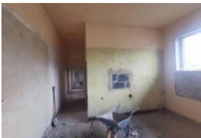
• Remont trybuny stadionu
