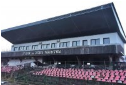
• Remont trybuny stadionu
