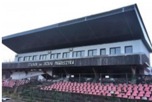
Remont trybuny stadionu
