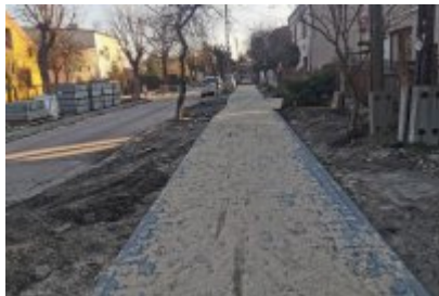
Remont ulicy Polnej w Czeladzi
