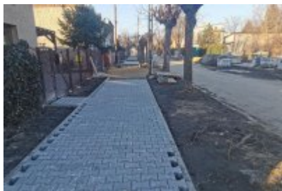
Remont ulicy Polnej w Czeladzi
