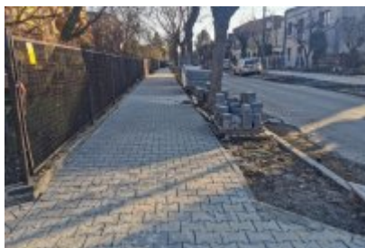
Remont ulicy Polnej w Czeladzi
