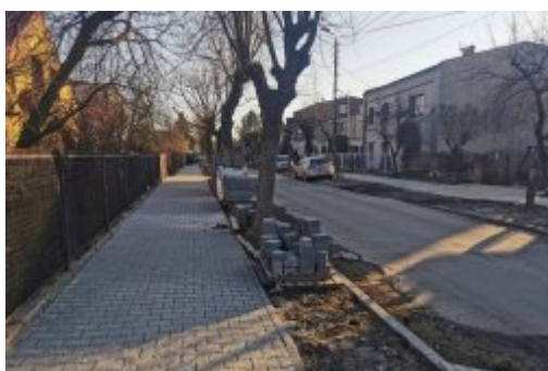
Remont ulicy Polnej
