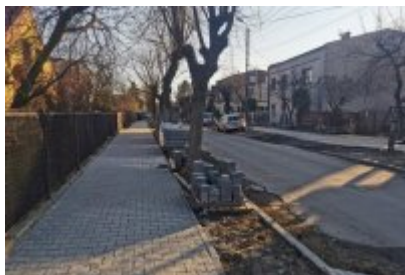
Remont ulicy Polnej w Czeladzi
