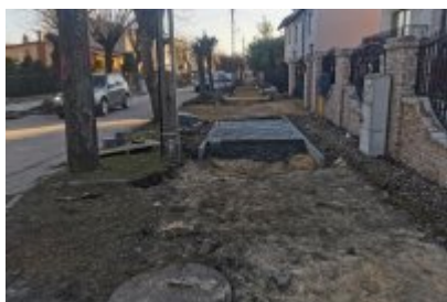
Remont ulicy Polnej w Czeladzi
