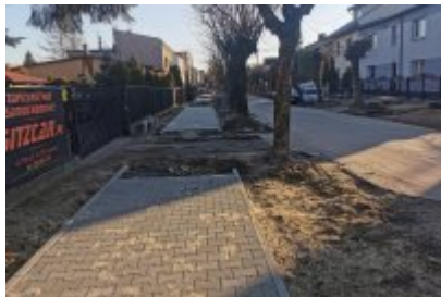
Remont ulicy Polnej w Czeladzi
