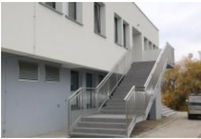
• Hala sportowa po termomodernizacji
