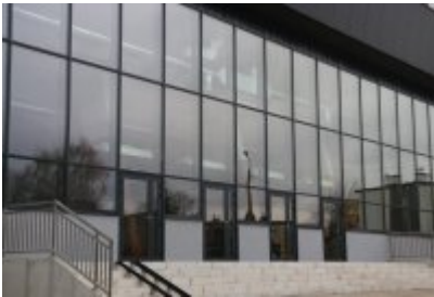
• Hala sportowa po termomodernizacji
