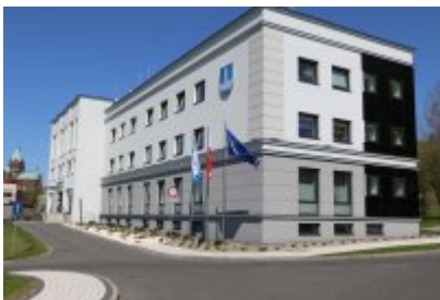
Termomodernizacja budynku Urzędu Miasta Czeladź
