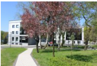
Termomodernizacja budynku Urzędu Miasta Czeladź
