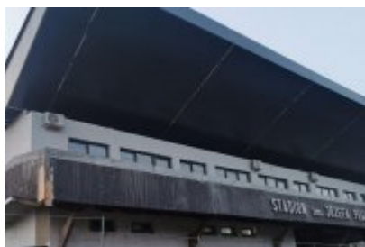
Remont trybuny stadionu
