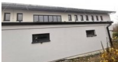
Remont trybuny stadionu
