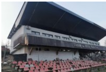
Remont trybuny stadionu
