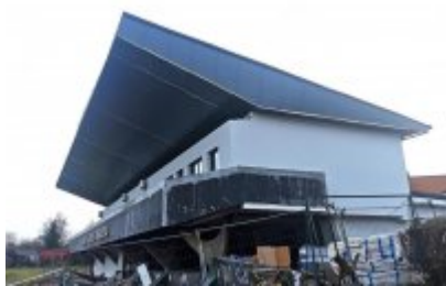
Remont trybuny stadionu
