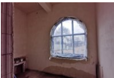
• Remont dawnej cechowni KWK Saturn w Czeladzi
