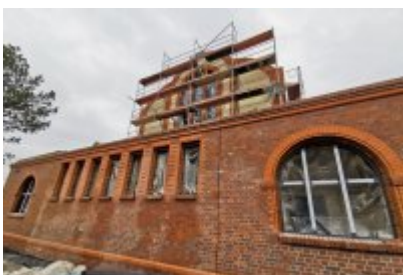
• Remont dawnej cechowni KWK Saturn w Czeladzi
