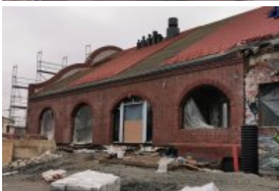
• Remont dawnej cechowni KWK Saturn w Czeladzi
