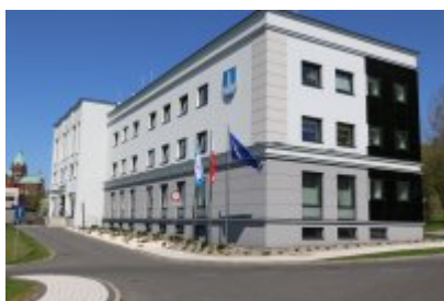
• Termomodernizacja budynku Urzędu Miasta Czeladź
