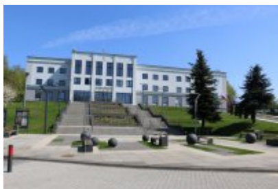
• Termomodernizacja budynku Urzędu Miasta Czeladź
