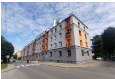
• Termomodernizacja budynku komunalnego przy ul. Tuwima
