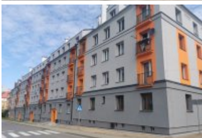
• Termomodernizacja budynku komunalnego przy ul. Tuwima
