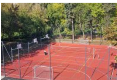
Modernizacja terenu przyszkolnego w SP4
