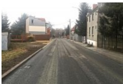
• Ulica Siemianowicka gotowa
