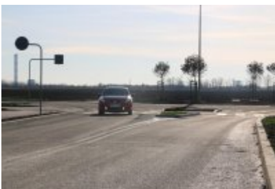
Obwodnica osiedla Piłsudskiego w Czeladzi
