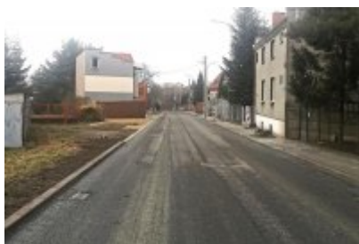
• Ulica Siemianowicka gotowa
