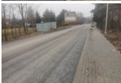
• Ulica Siemianowicka gotowa
