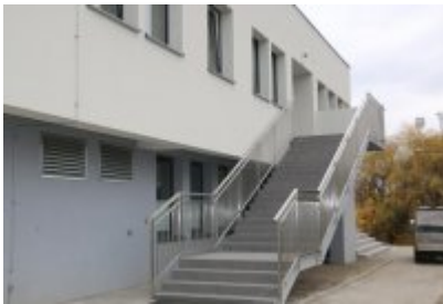
• Hala sportowa po termomodernizacji
