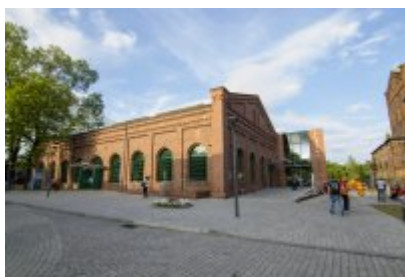
Rozruch Maszyn - Symfonia Hutnicza
