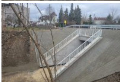
Nowopogońska już przejezdna
