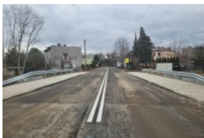
Nowopogońska już przejezdna
