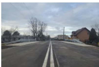
Nowopogońska już przejezdna
