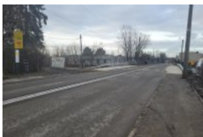
Nowopogońska już przejezdna
