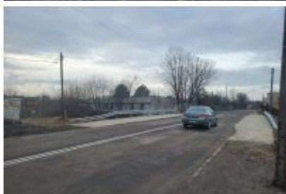
Nowopogońska już przejezdna
