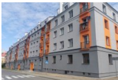
• Termomodernizacja budynku komunalnego przy ul. Tuwima
