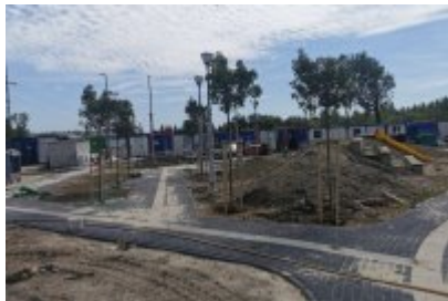
Drzewa wokół remontowanej cechowni
