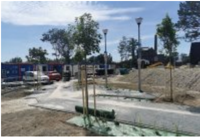
• Drzewa wokół remontowanej cechowni
