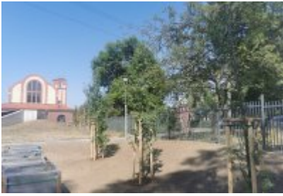
• Drzewa wokół remontowanej cechowni
