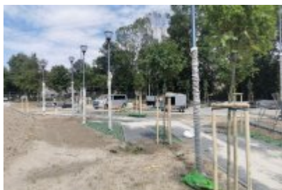
Drzewa wokół remontowanej cechowni
