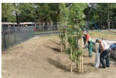
Drzewa wokół remontowanej cechowni
