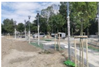
Drzewa wokół remontowanej cechowni
