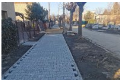
Remont ulicy Polnej w Czeladzi
