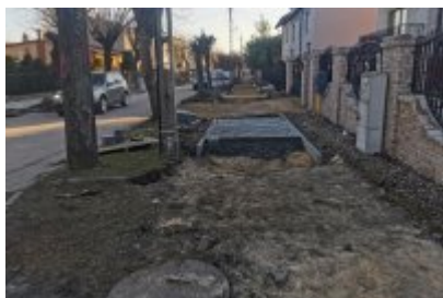
Remont ulicy Polnej w Czeladzi
