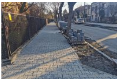
Remont ulicy Polnej w Czeladzi
