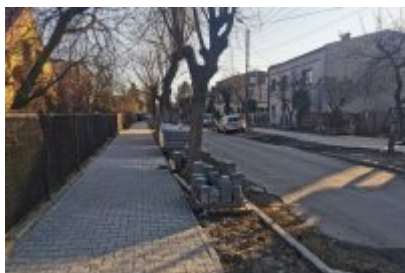
Remont ulicy Polnej w Czeladzi
