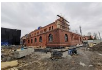
Remont dawnej cechowni KWK Saturn w Czeladzi
