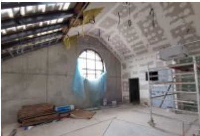
• Remont dawnej cechowni KWK Saturn w Czeladzi
