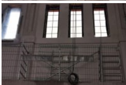
• Remont dawnej cechowni KWK Saturn w Czeladzi
