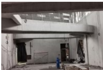
• Remont dawnej cechowni KWK Saturn w Czeladzi
