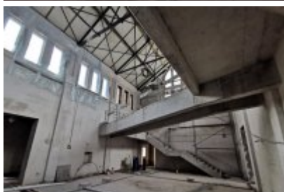
• Remont dawnej cechowni KWK Saturn w Czeladzi
