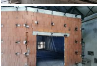
• Remont dawnej cechowni KWK Saturn w Czeladzi
