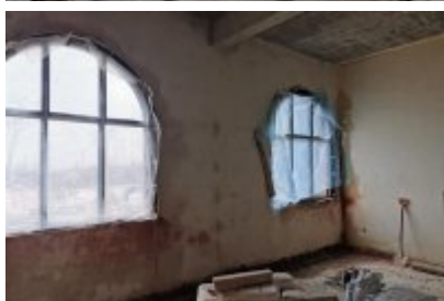
• Remont dawnej cechowni KWK Saturn w Czeladzi
