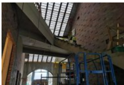
• Remont dawnej cechowni KWK Saturn w Czeladzi
