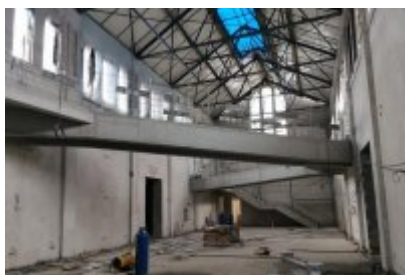
• Remont dawnej cechowni KWK Saturn w Czeladzi
