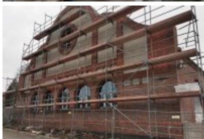
• Remont dawnej cechowni KWK Saturn w Czeladzi
