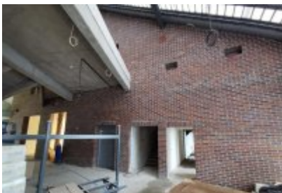
• Remont dawnej cechowni KWK Saturn w Czeladzi
